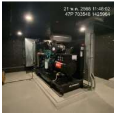
รูปที่ 17 เครื่องกำเนิดไฟฟ้าฉุกเฉิน
