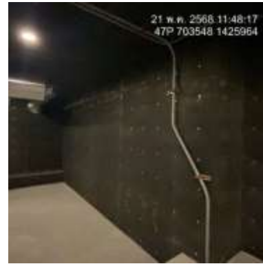
รูปที่ 19 บุผนังทุกด้านและเพดานของเครื่องกำเนิดไฟฟ้าด้วยวัสดุกันเสียง
