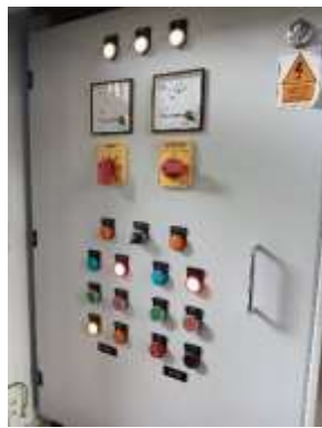
รูปที่ 10 ระบบมิเตอร์ไฟฟ้าสำหรับระบบบำบัดน้ำเสีย
