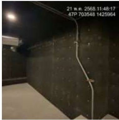
รูปที่ 19 บุผนังทุกด้านและเพดานของเครื่องกำเนิดไฟฟ้าด้วยวัสดุกันเสียง
