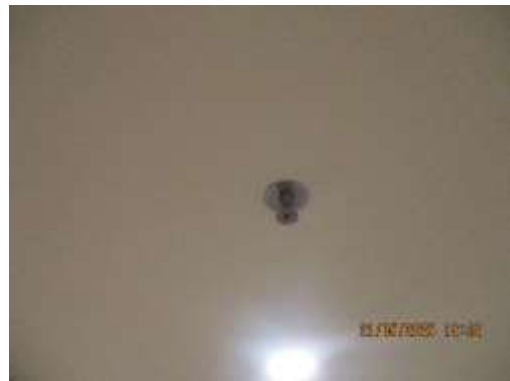
รูปที่ 28 เครื่องตรวจจับความร้อน
