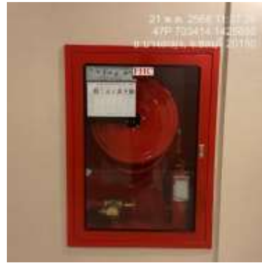
รูปที่ 24 ตู้เก็บสายฉีดน้ำดับเพลิงพร้อมอุปกรณ์ (FHC)
